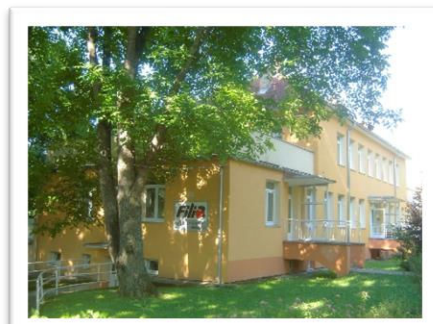
Obrázek 4 Budova Azylového domu Filia
