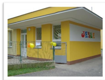
Obrázek 3 Budova Jeslí Čěčova
